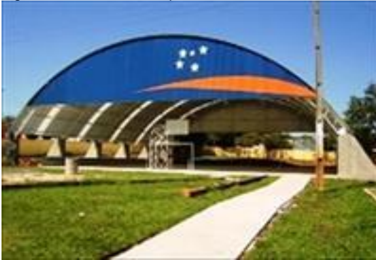
Figura 06 - Quadra Desportiva Coberta
