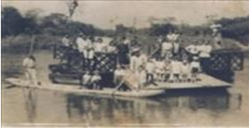
Figura 04 - Balsa transportando passageiros pelo Rio Itararé
